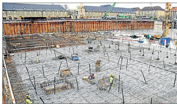
Armeringsarbejdet er gået i gang. (Foto: NCC)
