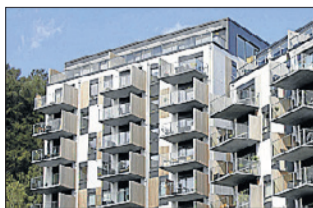
På fabrikken i Randers har man specialiseret sig i at producere sandwichelementer i beton. Her har virksomheden leveret til et projekt i Vejle i 2019. (Foto: Confac)
