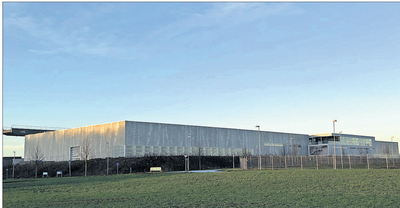
Som led i opførelse af Confacs nye, og højt automatiserede produktionshal - en udvidelse på cirka 6.000 kvm med en produktionslinje på 180 meter under samme tag - er der etableret nyt indgangsparti og nye velfærdsområder for medarbejderne. (Foto: Confac)
