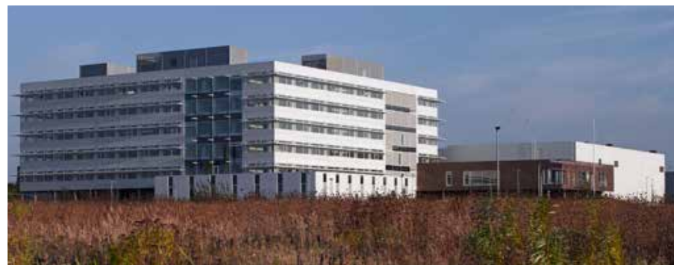
Skanderborgs nye rådhus opført med betonelementer har fået DGNB-certifikat med platin i bæredygtighed. Foto Confac EH
